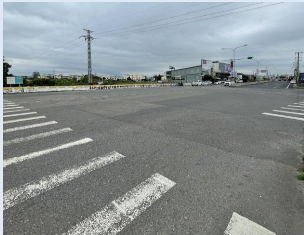
捷運綠線延伸工程 台1丙/台14丙路口現況
