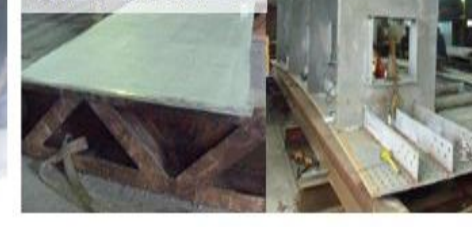
先鍍鋅後銲接工法
