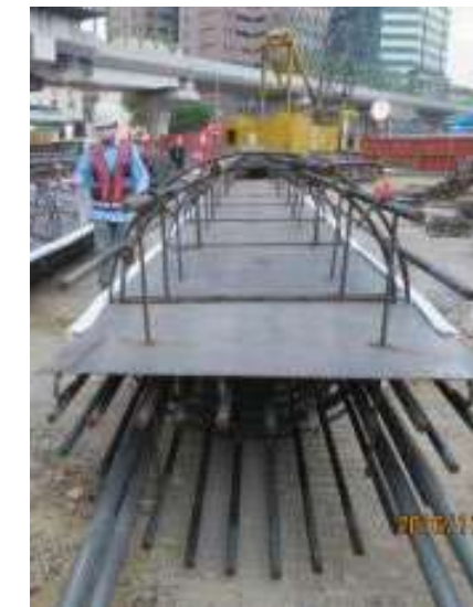
半圓形全套管樁鋼筋籠
