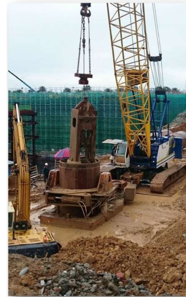
半圓形全套管擋土樁示意圖
