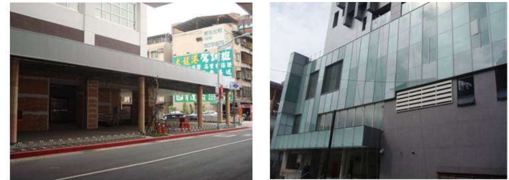
土開大樓施工中捷運外牆以石頭漆設置
