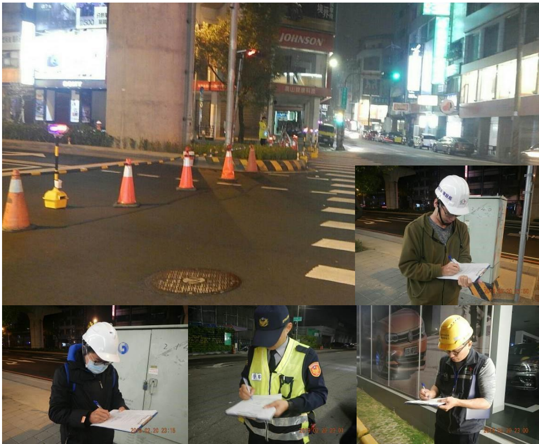
圖 7 臺中市政府辦理捷運綠線夜間施工聯合稽查
