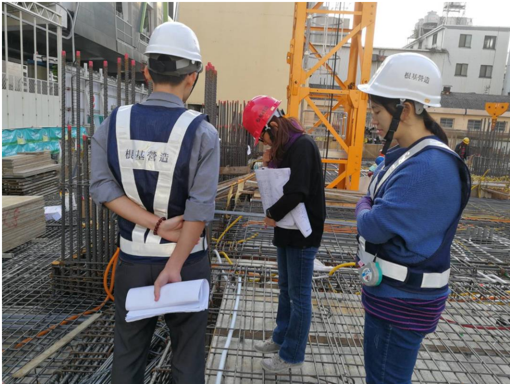
圖 6 臺中市政府辦理捷運綠線共構場站基地施工稽查
