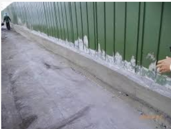
工地圍籬設置防溢座
