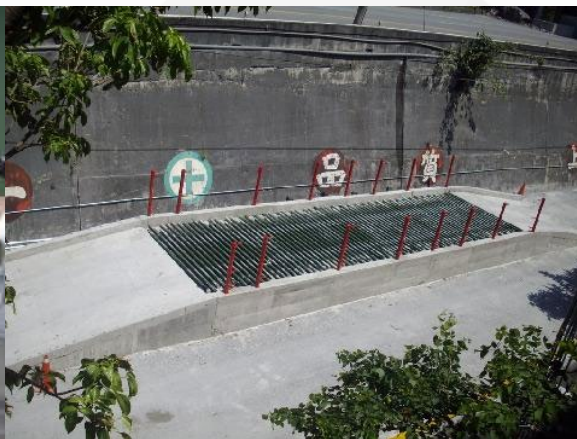
工區設置洗車台
