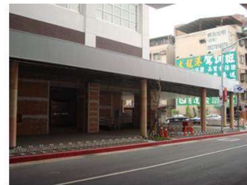
土開大樓施工中捷運外牆以石頭漆設置 土開大樓直接覆蓋石頭漆之外牆花崗石及玻璃
