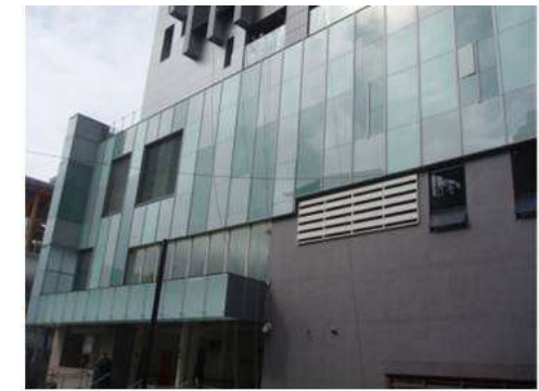
土開大樓施工中捷運外牆以石頭漆設置 土開大樓直接覆蓋石頭漆之外牆花崗石及玻璃
