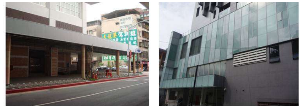
土開大樓施工中捷運外牆以石頭漆設置 土開大樓直接覆蓋石頭漆之外牆花崗石及玻璃
